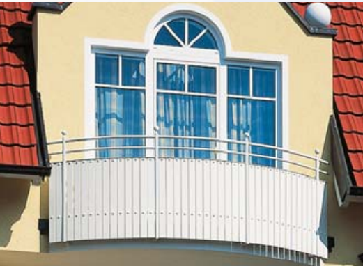
Revestimientos de balcones
